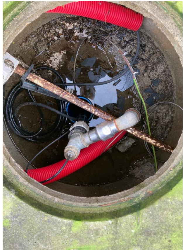
Vue dans le regard du forage existant
