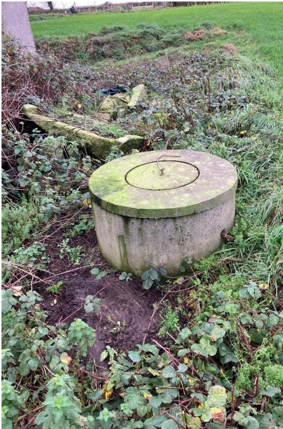
Vue sur le forage existant
